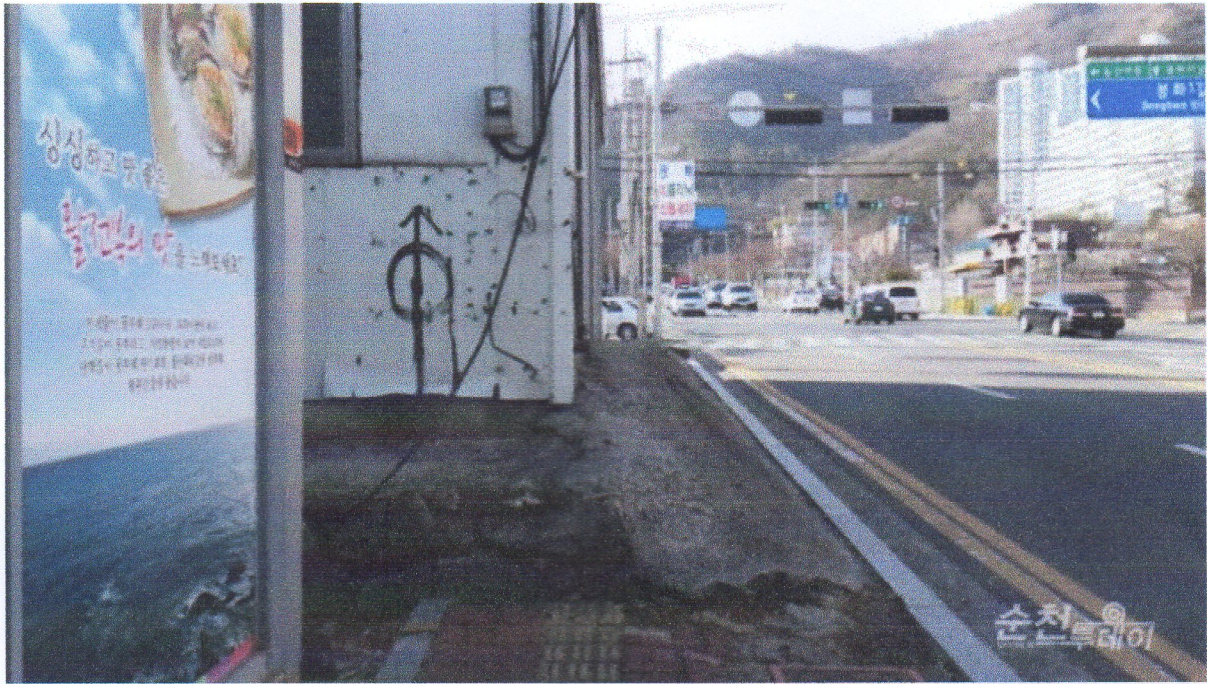
▲ A씨가 건축물을 지은 후에 시가 봉화터널과 도로를 내면서 A씨의 건축물 위치에는 인도를 확보하지 못해 인도가 끊긴 상태.
